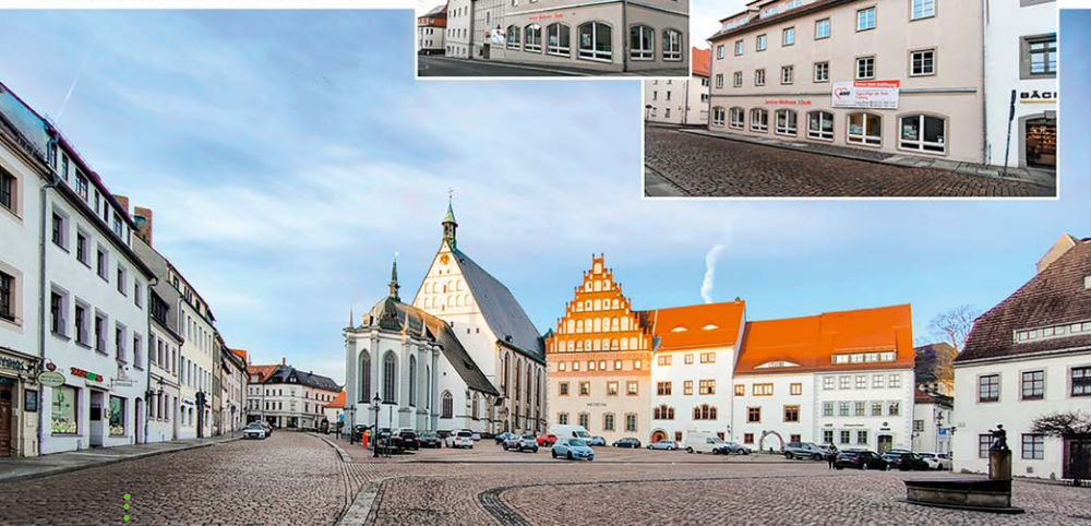
Untermarkt Freiberg mit dem Gebäude des Service-Wohnens am Dom, Fotos: Manuela Hamburg
