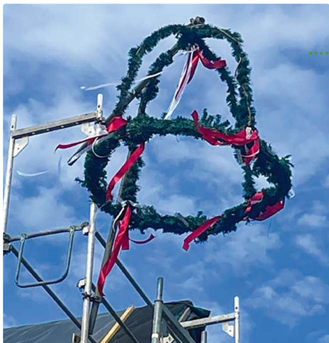
Unser Richtkranz zum Richtfest des Vierseitenhofes in Lottengrün
