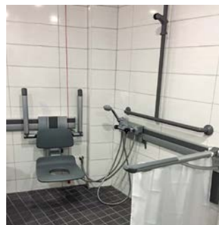
Das neu sanierte Bad.
