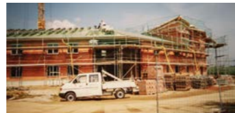
Baufortschritt der Wohnheime für Menschen mit Behinderungen, Foto: Karsten Reinke
