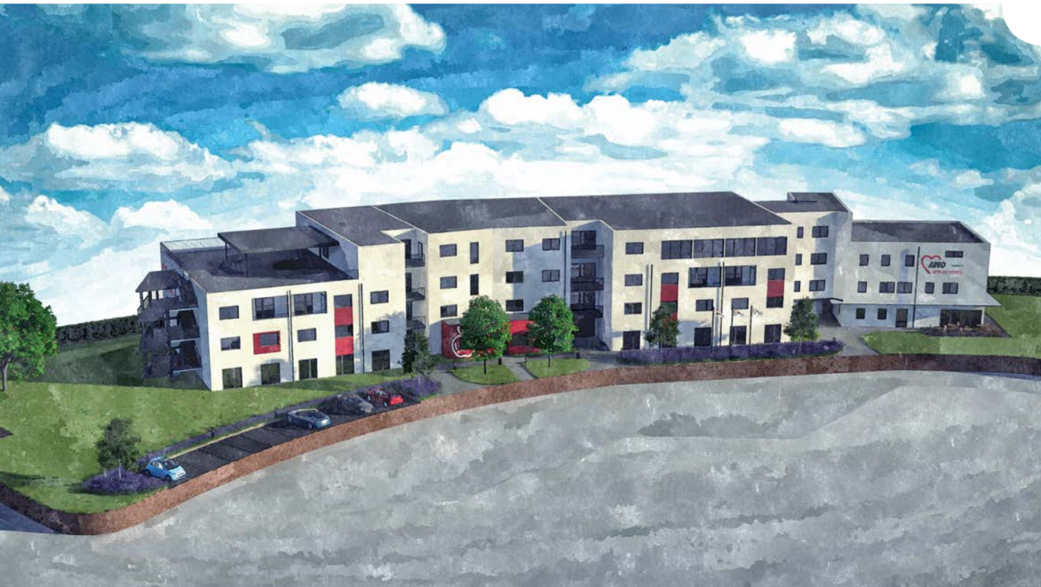
So soll die geplante Pflegeeinrichtung mit Servicewohnen in der Hoyerswerdaer Neustadt aussehen. Visualisierung: AWO Lausitz
