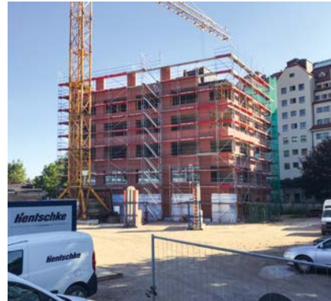
Ein Jahr später, im Juni 2018, steht der Rohbau.
